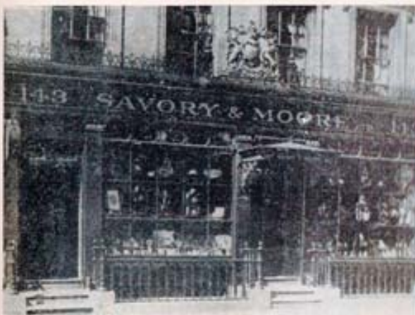
Průčelí anglické lékárny
