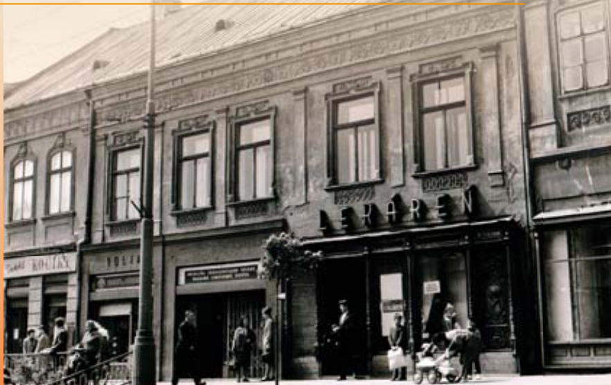
↑ Portál lekárne U sv. Trojice z roku 1965
